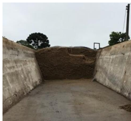
Figura 2 – Fotografia de silo de trincheira com construção em alvenaria
