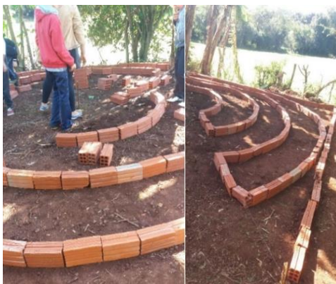
Figura 2 – Construção da Mandala
